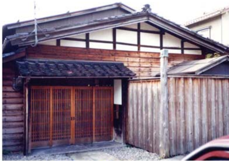
Ashigaru house 足輕住宅
